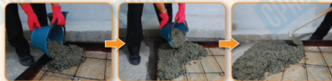
การเทคอนกรีตจากขอบด้านนอกเข้ามา เป็นลำดับขั้นตอน
