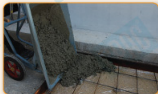
การลำเลียงคอนกรีตด้วยรถเข็น และ Belt Conveyor
