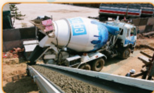
การลำเลียงคอนกรีตด้วยรถเข็น และ Belt Conveyor
